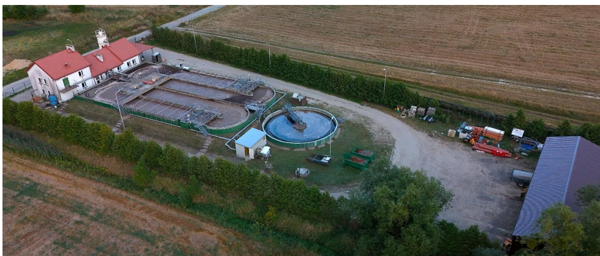
Fot. nr 41, Oczyszczalnia ścieków w Sobolewie
