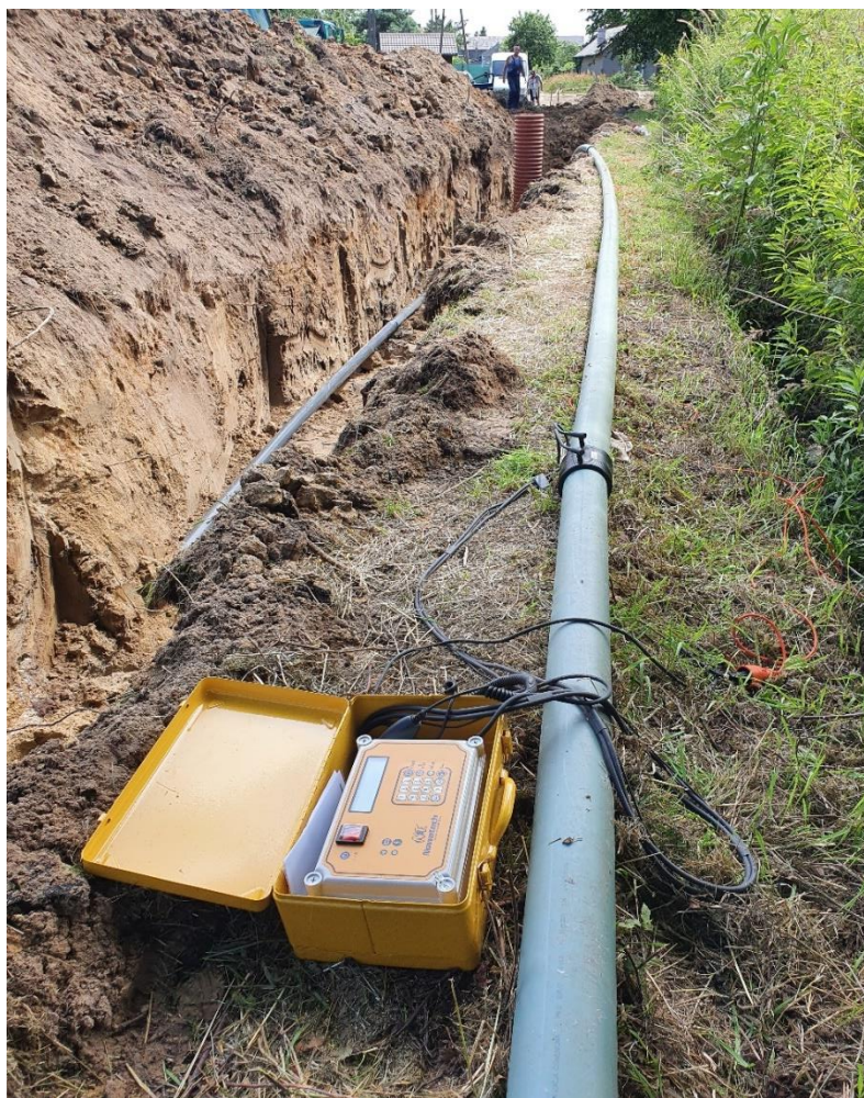
Fot. nr 38, Budowa kanalizacji Sobolew, ul. Piaskowa
