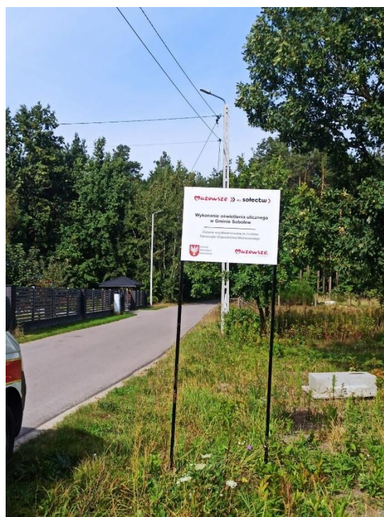
Fot. nr 51, Modernizacja drogi w Godziszu
