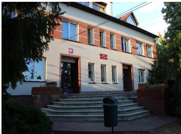
Fot. nr 70, Publiczna Szkoła Podstawowa w Sokole
