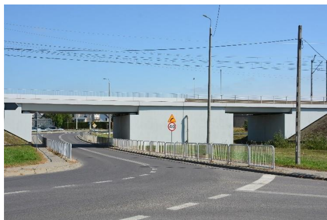
Fot. nr 47, Wiadukt kolejowy w Sobolewie
