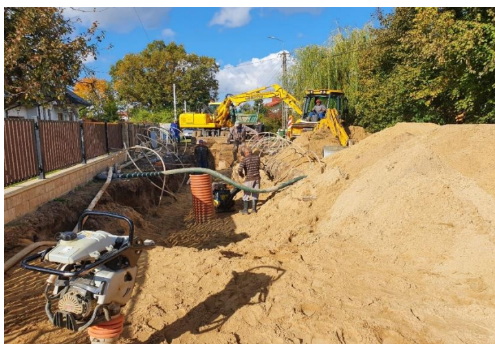
Fot. nr 37, Budowa kanalizacji Sobolew, ul. Leszczynowa
