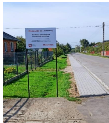
Fot. nr 53, Budowa chodnika w Trzciance
