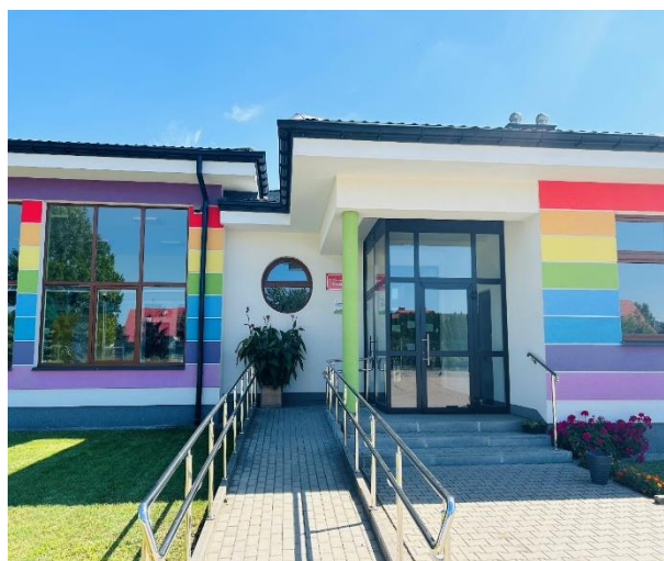
Fot. nr 67, Publiczny Żłobek w Sobolewie
