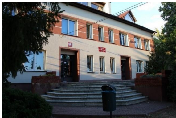
Fot. nr 61, Publiczna Szkoła Podstawowa w Sokole
