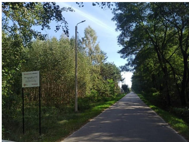
Fot. nr 48, Modernizacja drogi w Kaleniu Drugim
