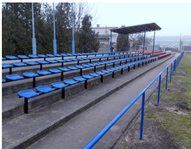
Fot. nr 84, Trybuny na stadionie w Sobolewie
